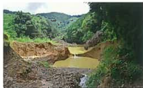
豪雨によるため池堤体の崩壊
