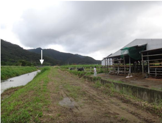
図 5. 牛舎と大美川. 川幅は狭く川底も浅い. 橋 (矢印) の上流で 2 本の支流が合流している.
