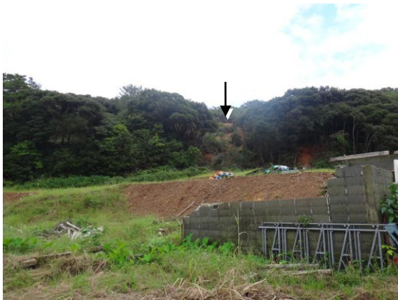
図3. 農場の全景. 中央の黄色い山肌が崩落部位(矢印). ブロック塀は土石流で破壊された牛舎跡.
