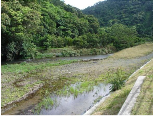
図 5 滞筋位置を固定し良好な低水路幅（画面奥）を保全した役勝川上役勝地区
