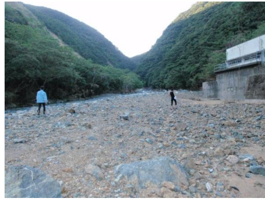
図 6 旧採石場周辺の斜面崩壊により河床が土砂に埋まった住用川ダム放水口前
