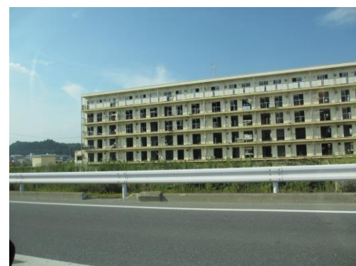
写真 6 4階まで津波が襲ったアパート (大船渡市)
