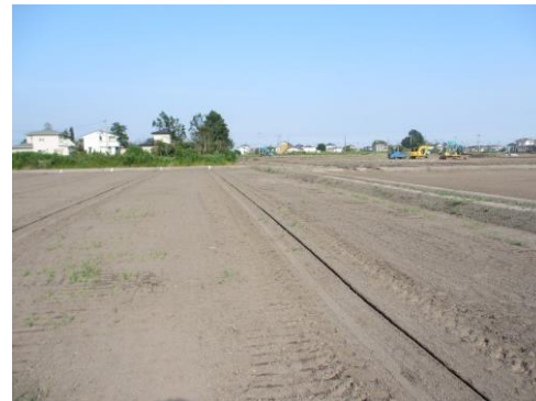
写真 10 弾丸暗渠による除塩
