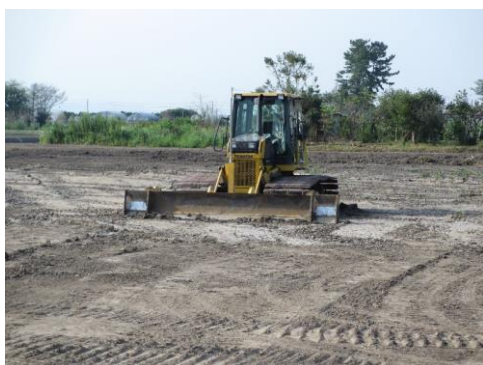
写真 11 農地の表土剥ぎ (宮城県山元町)
