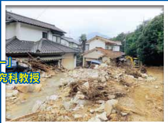
可部東6丁目の谷すじの家屋の被災状況(道路勾配4°)
