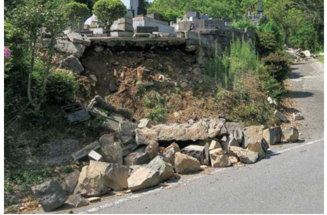
写真1 盛土地での小規模崩壊（宇城市）
