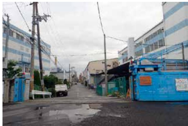
(b) 尻無川左岸の市街地（奥）と尻無川左岸1号防潮鉄扉（手前右側）
