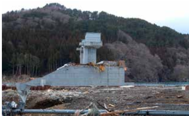
(a) 甫嶺川水門付近
