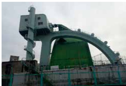
(b) 木津川水門の左岸側の側面
