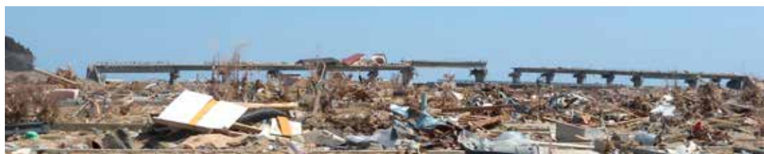
図-3 JR 気仙沼線の落橋 (2011年4月5日撮影)
