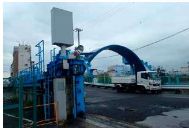
(a) 尻無川水門（奥）と尻無川左岸1号防潮鉄扉（手前左側）
