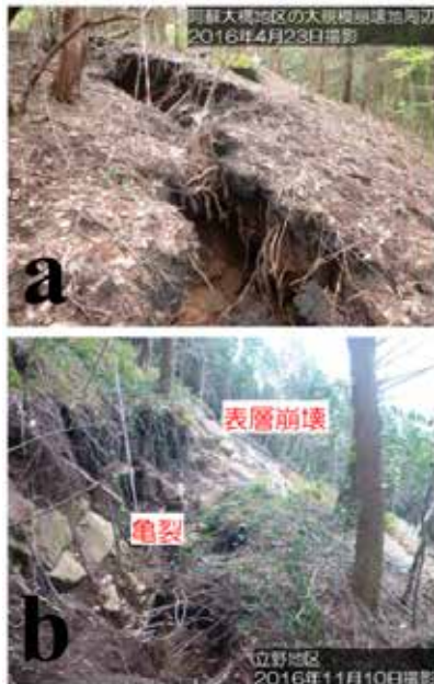
図-3.4 地震で生じた亀裂
