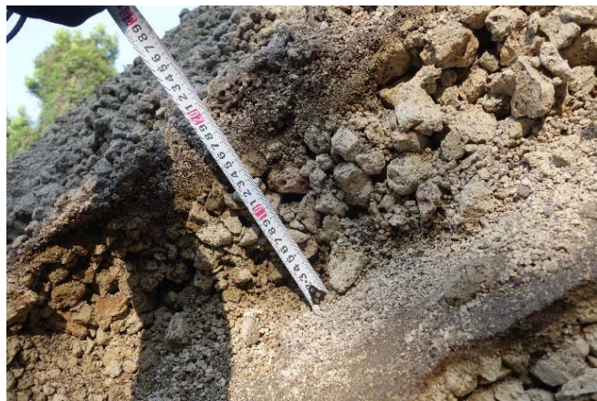
写真-5 崩壊箇所の表層土の状況
