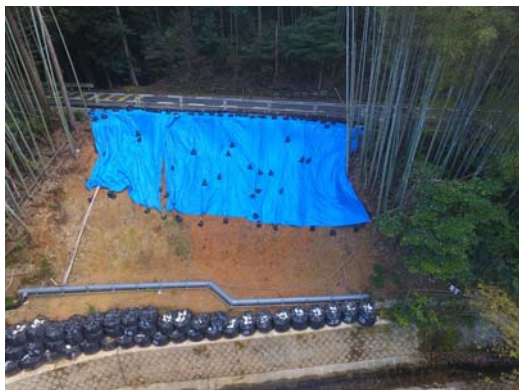
画像-1 ドローンによる現場空撮
