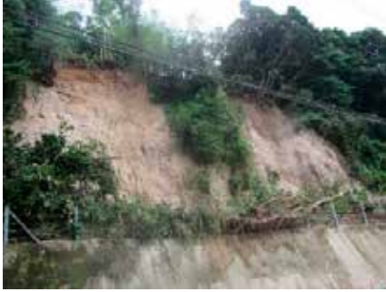
写真-1 斜面崩壊状況
