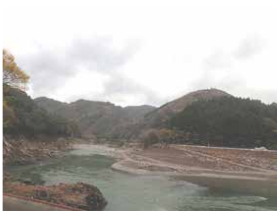
写真-3 球磨川河道の現況
