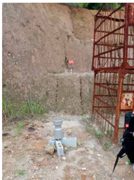
写真-1 現地計測の様子
