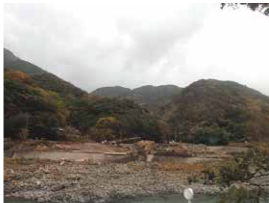
写真-2 球磨川堤防法面の崩壊
