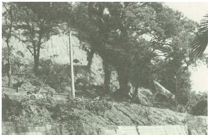
写真一10 シラス斜面下部における樹木の滑落土砂抑止効果
