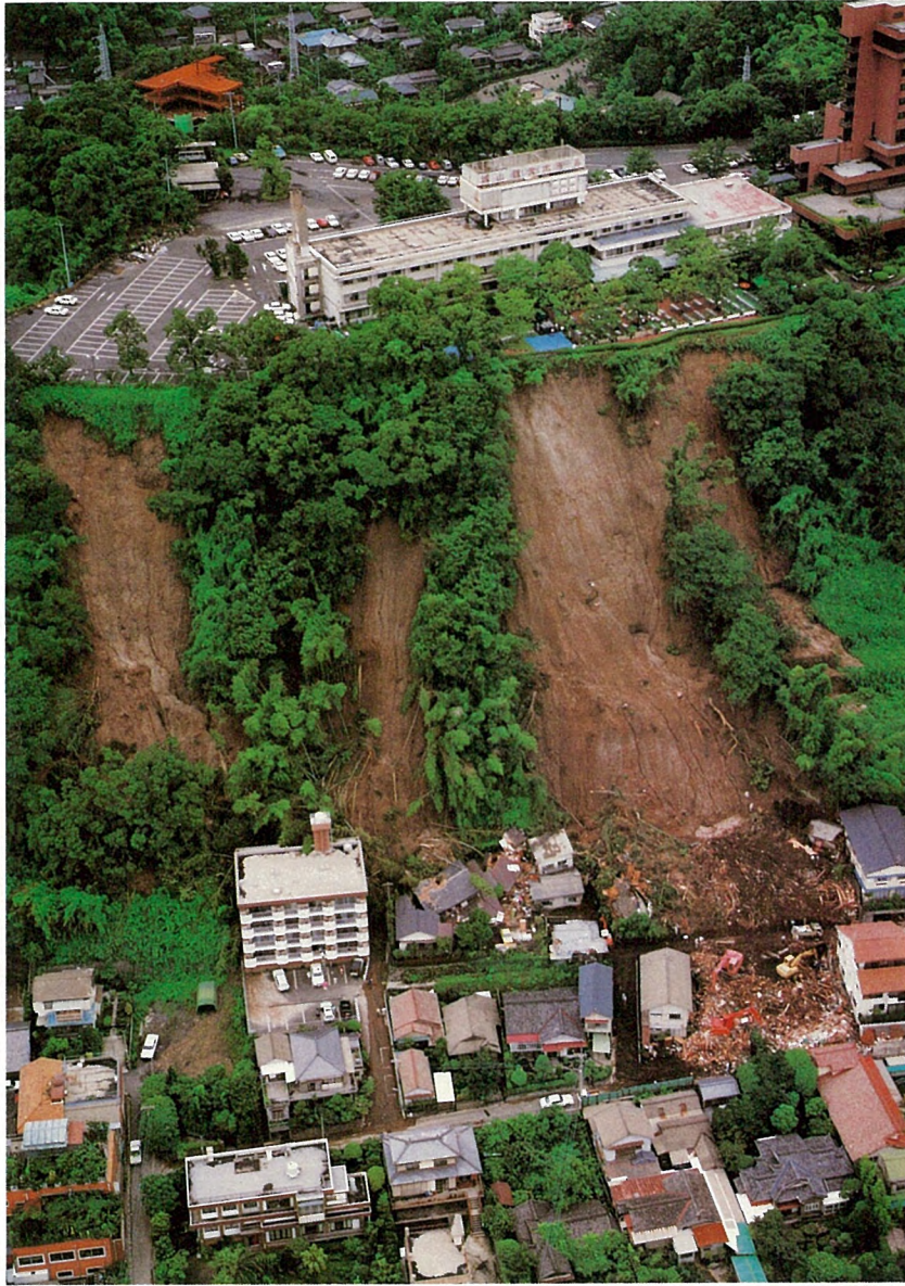
鹿児島市平之町災害現場（提供 国際航空写真株式会社）
