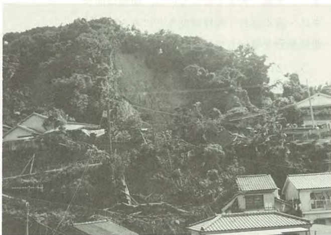
写真-1 上竜尾町崩壊地
