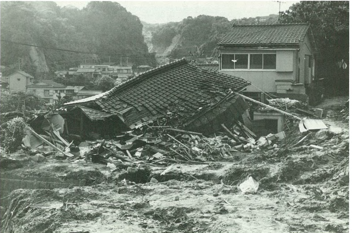
同上被害状況（提供 応用地質株式会社）
