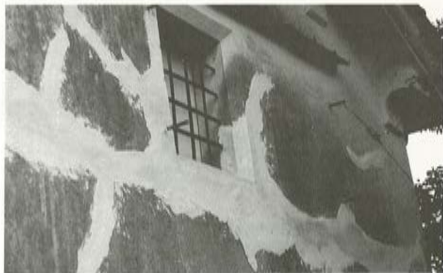
写真8 修理後の伊藤家の蔵 (5月24日撮影)
