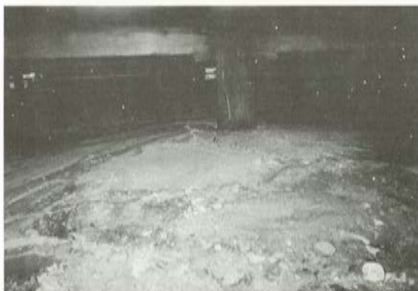
写真-2.4 民家の床下からの噴砂噴水現象の痕跡
