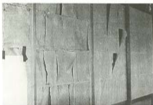
写真13 障子の変形
