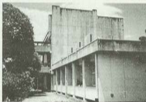
写真 30 宮之城農業高校特別教室棟東端 (2, 3 階はセットバックしている)
