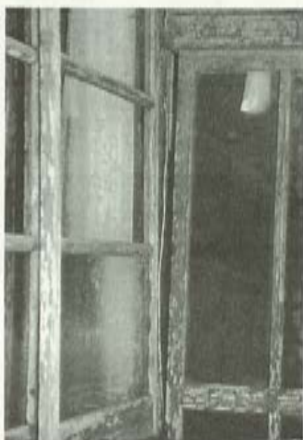
写真8 木製サッシの建て付け
