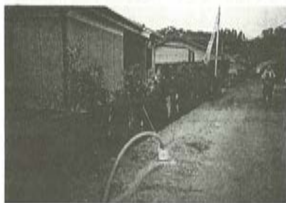
写真25 液状化 道路沿に砂が噴出
