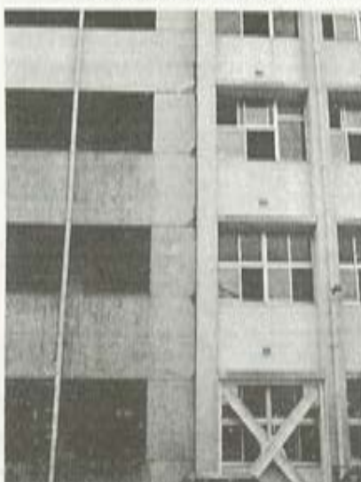
写真 47 川内高校特別教室棟と普通教室棟の エキスパンション・ジョイント
