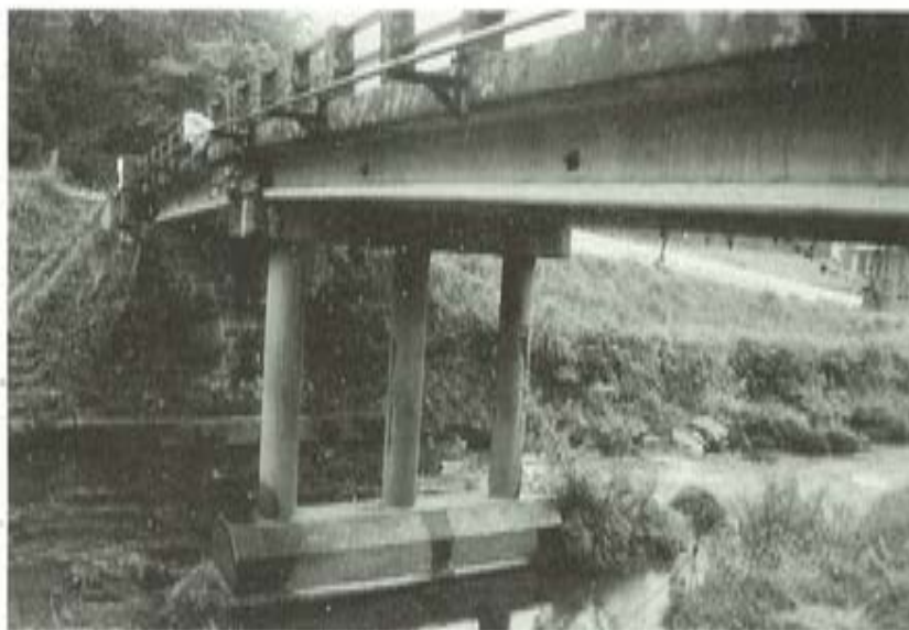
写真3 天神橋 橋脚と右岸橋台
