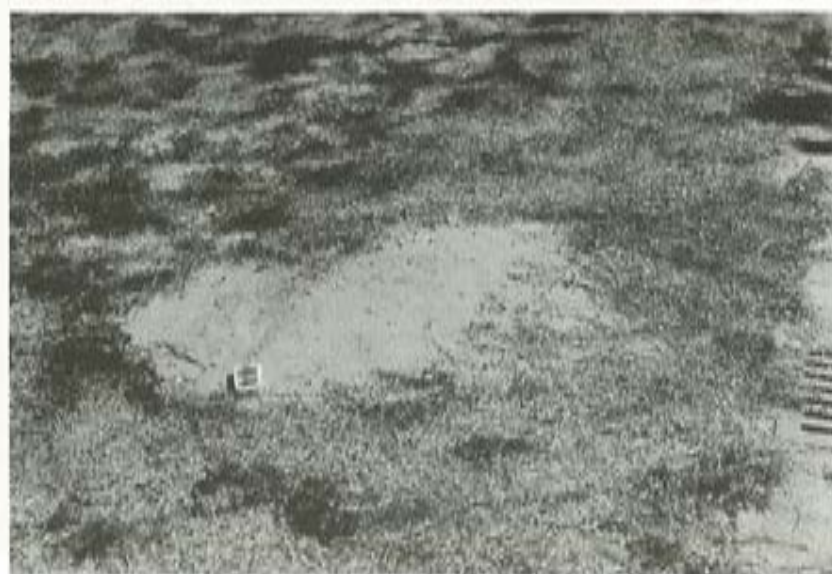
写真-2.3 水産加工団地背後の公園（晴海町運動公園）での噴砂状況
