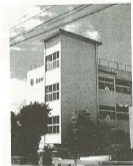
写真 8 盈進小(管理教室棟東端の連続耐震壁)
