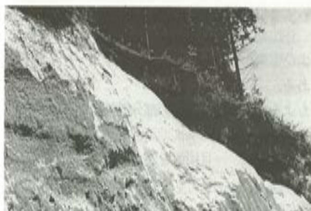
写真23 風化花崗岩(マサ土)崖の崩壊
