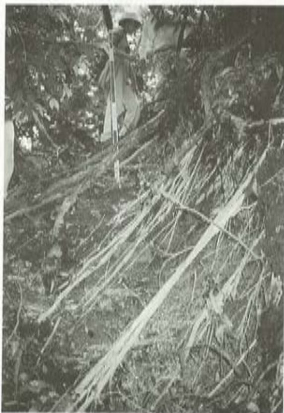
写真1 3月26日の地震によりマサ斜面に発生したクラック（1997年5月10日撮影） 5月13日の地震によりクラック付近から崩壊（幅15m、長さ30m、深さ1m）が発生した。
