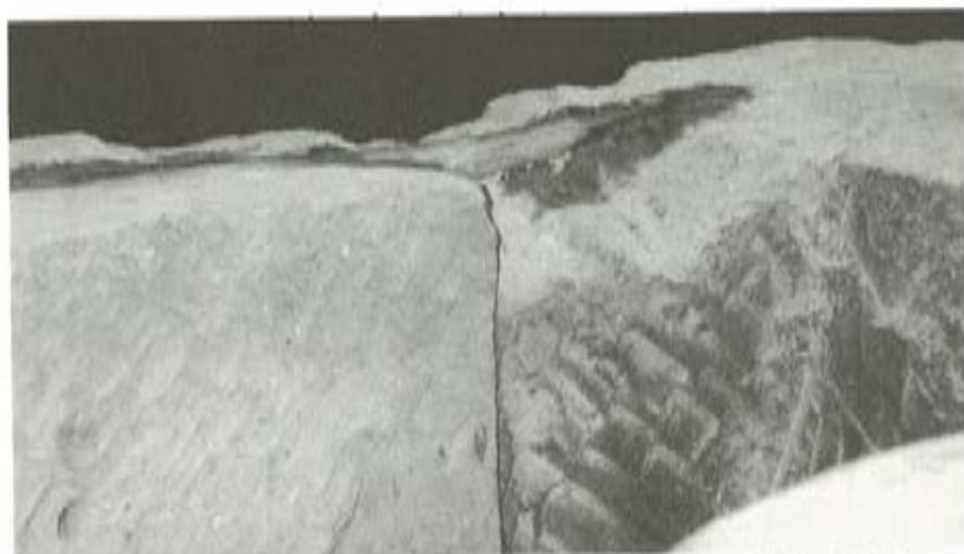
写真5 ステンレスのかすがいを入れてエポキシ樹脂で固めた
