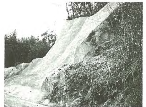
写真-1 農道脇の法面工
