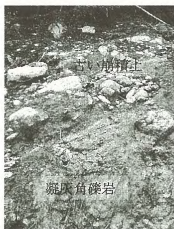
写真-6 熱水変質した凝灰角礫岩を覆う古い崩積土
