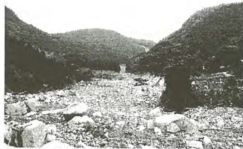
写真-1 水俣市宝川内集川の土石流跡
