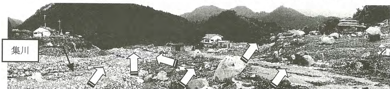
写真-2 水俣市宝川内集集落の土石流経路と被災状況
