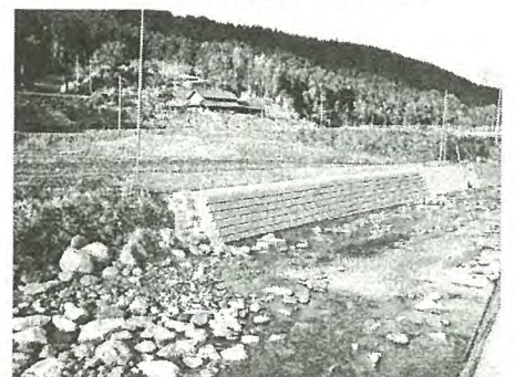
写真-2 河川護岸の改修
