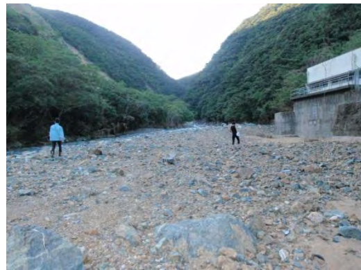
図 6 旧採石場周辺の斜面崩壊により河床が土砂に埋まった住用川ダム放水口前
