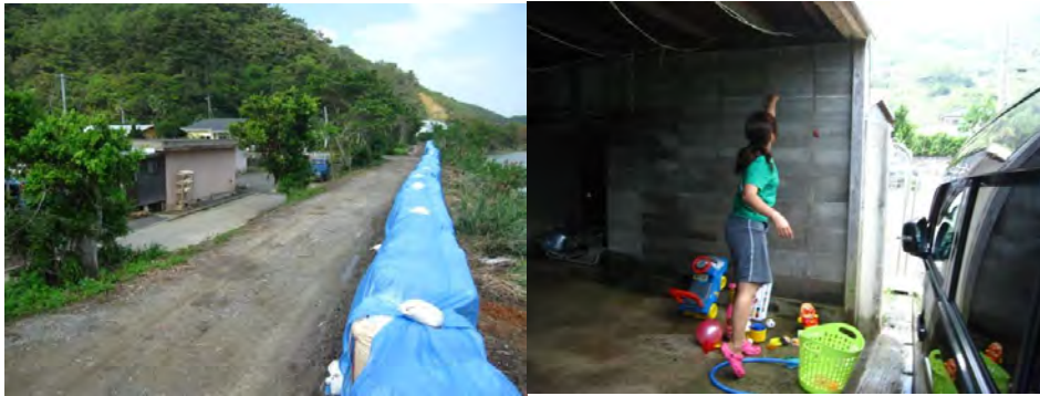
[昨年と同一カ所の決壊と応急的土嚢(戸口川)、後片づけ作業中に昨年より 30cm 高い水位であったと昨年のマーク個所と比較して示している(戸口)]
