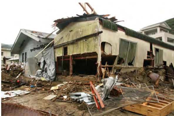
1F部分の破壊された収蔵庫
