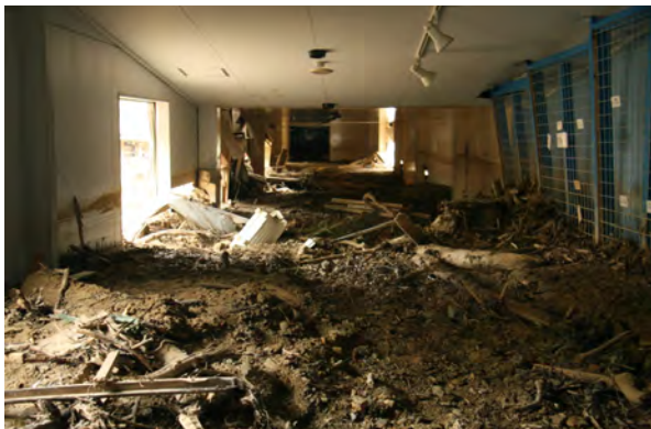
土石流が内部に入る展示通路
