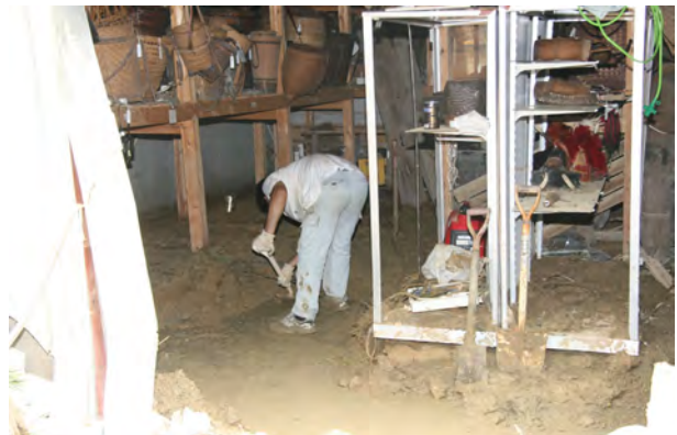
被災収蔵庫内の土石流除去作業
