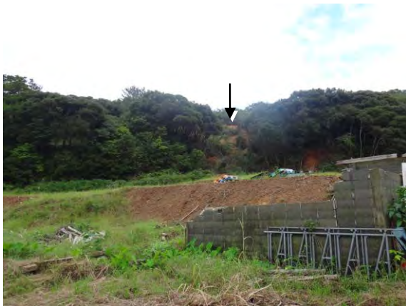
図 3. 農場の全景。中央の黄色い山肌が崩落部位 (矢印)。ブロック塀は土石流で破壊された牛舎跡。
