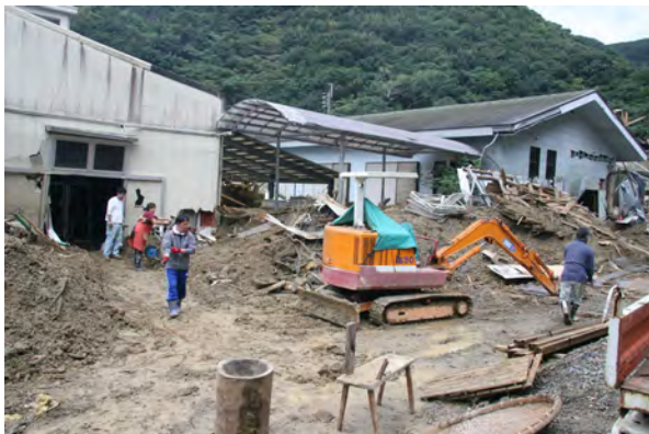
土石流除去および資料回収作業
