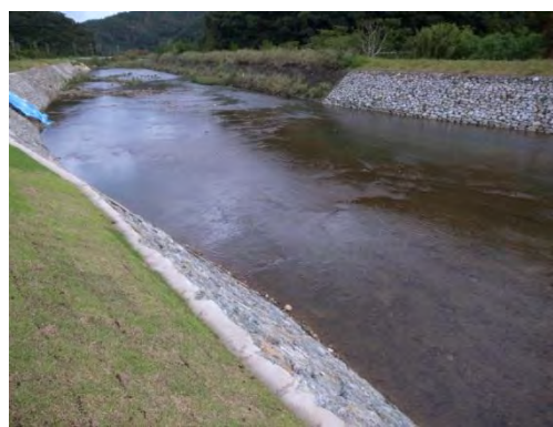
図4 役勝川役勝地区では拡幅により流れが浅く遅くなり、産卵不適の環境に移行しつつあり、滞筋固定の対策が必要
