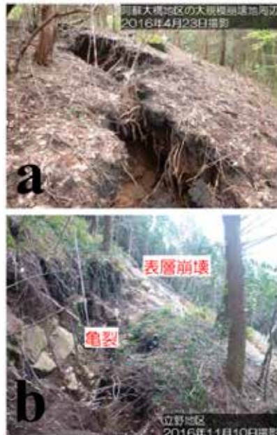
図-3.4 地震で生じた亀裂
