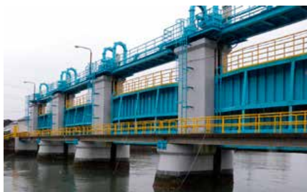
図-4 宮城県の八幡川防潮水門 (2010年4月12日撮影)
