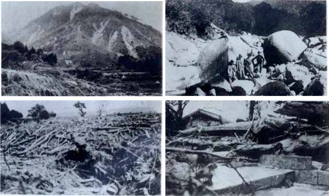
写真 3.3.1 被害状況（西ら，1938）
