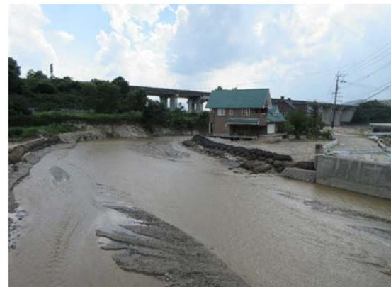
写真-18 赤谷川の増水による護岸崩壊
