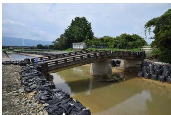
写真-6 河川増水による橋梁の被害
