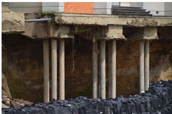
写真-5 校舎基礎下の剥きだしの支持杭
