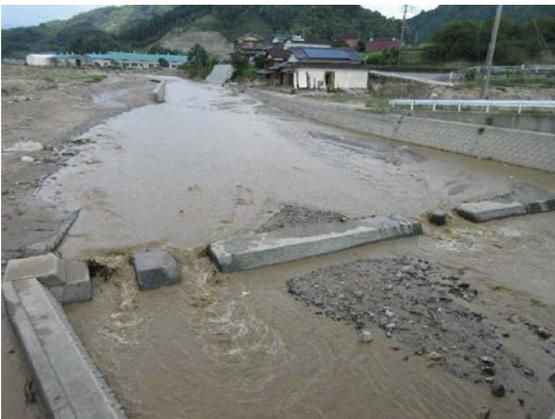
写真-19 井堰の崩壊（赤谷川）
