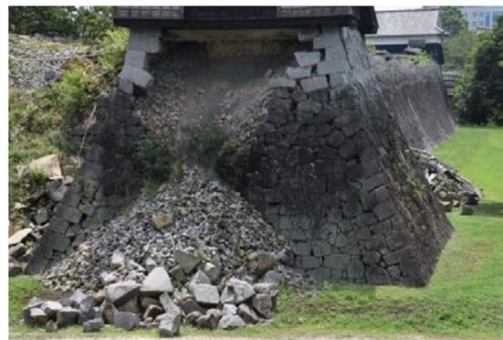
写真-1 熊本城の石垣の崩壊（熊本市）
