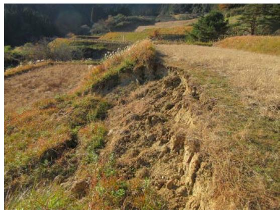
写真-24 地割れによる農地法面の崩壊
