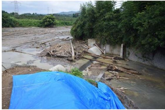
写真-6 土砂で埋没したため池と余水吐
