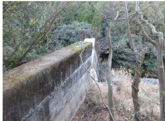
写真-26 地すべりによる砂防ダム堰堤の崩壊
