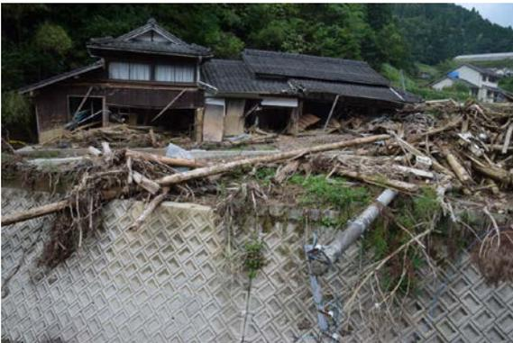
写真-15 土石流による家屋の被害
