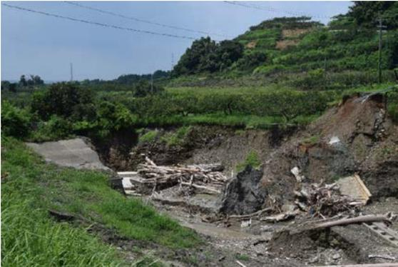
写真-7 ため池堤体の喪失（朝倉市）
