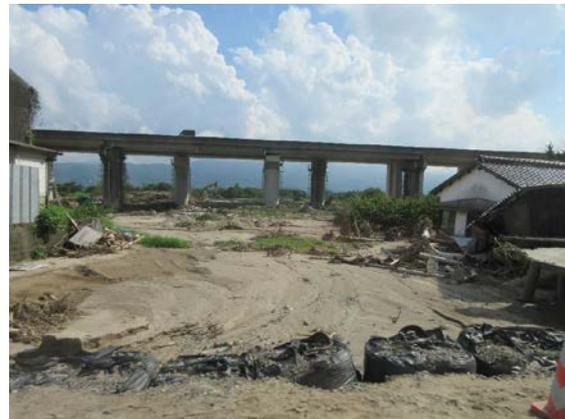
写真-20 大分自動車道下に堆積した土砂
