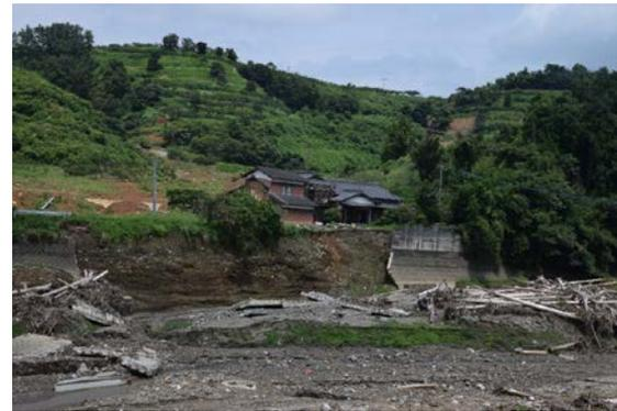
写真-8 ため池護岸の崩壊（朝倉市）
