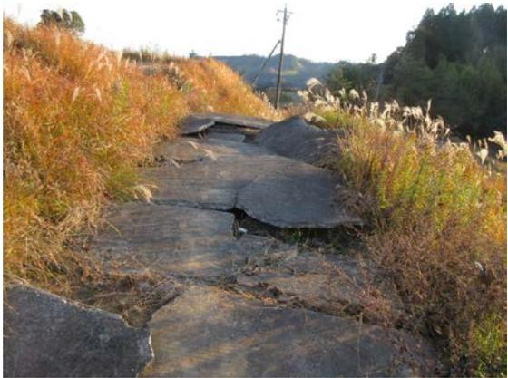
写真-23 地すべりにより屈曲した農道
