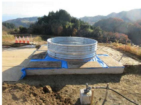
写真-22 地下水調査のための集水井
