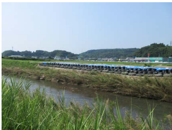
写真-1 いちき串木野市大里川の堤防決壊
