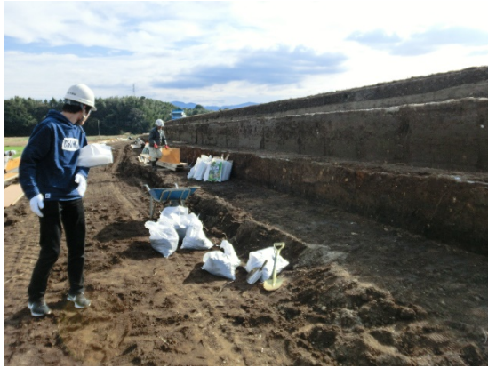
写真-2 堤体土の採取状況
