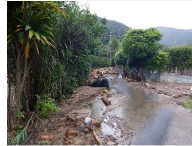
写真1 災害発生後の道路
