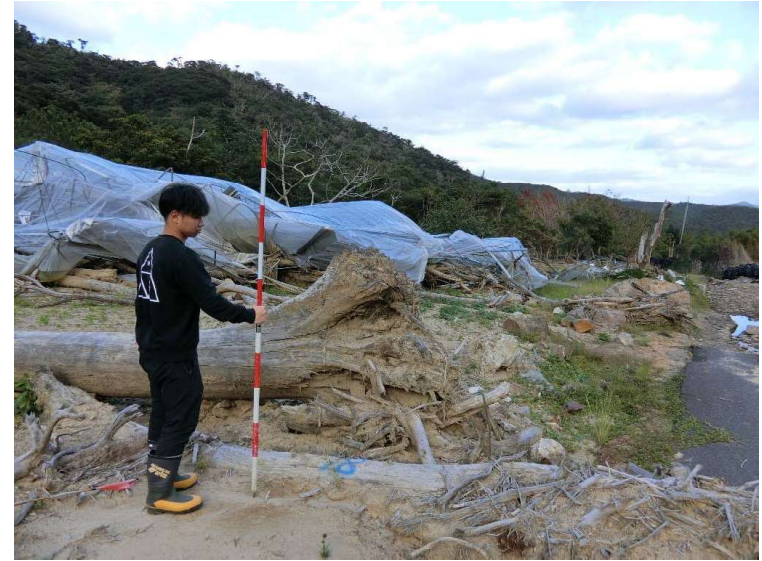
写真7 土石流で倒壊したビニルハウス
