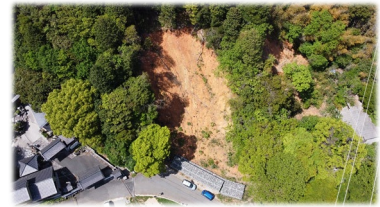
ドローンによる崩壊斜面の空撮
