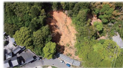
ドローンによる崩壊斜面の空撮
