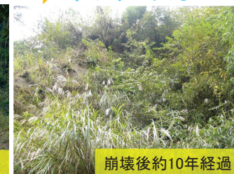
崩壊発生直後
